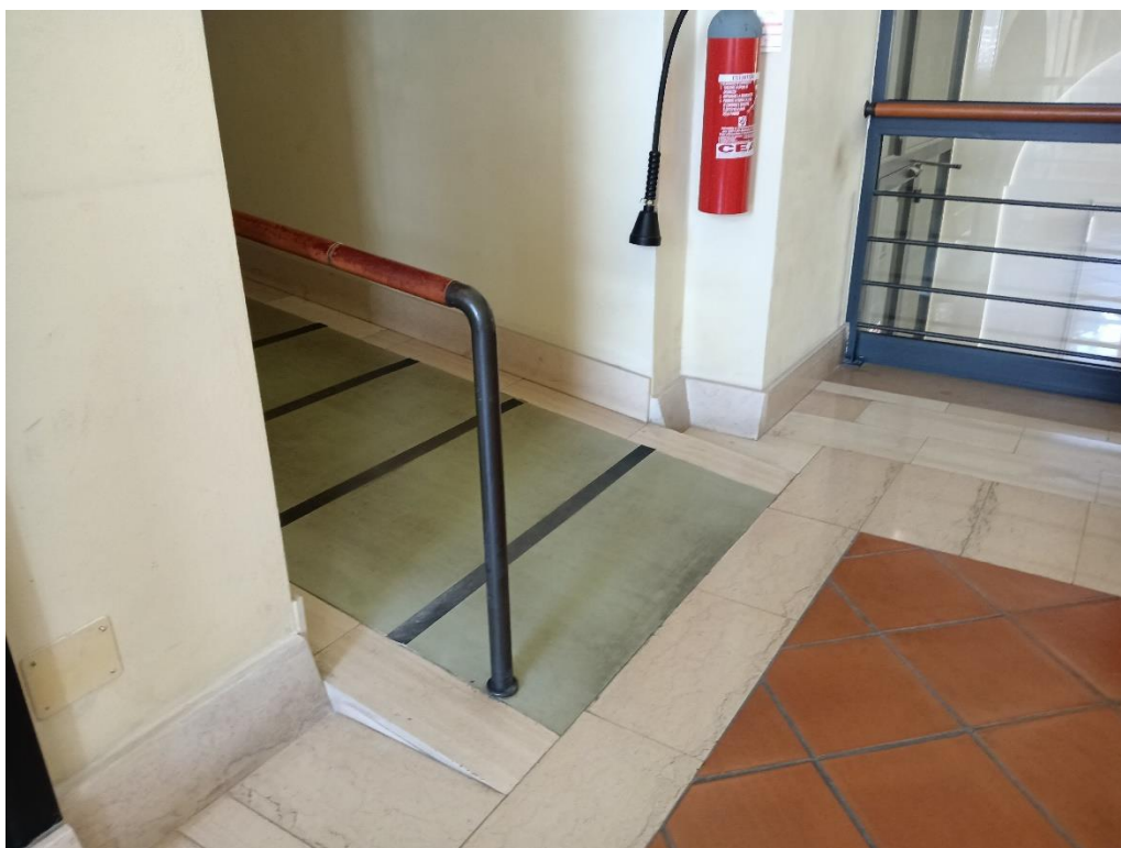
Particolare corrimano della rampa
