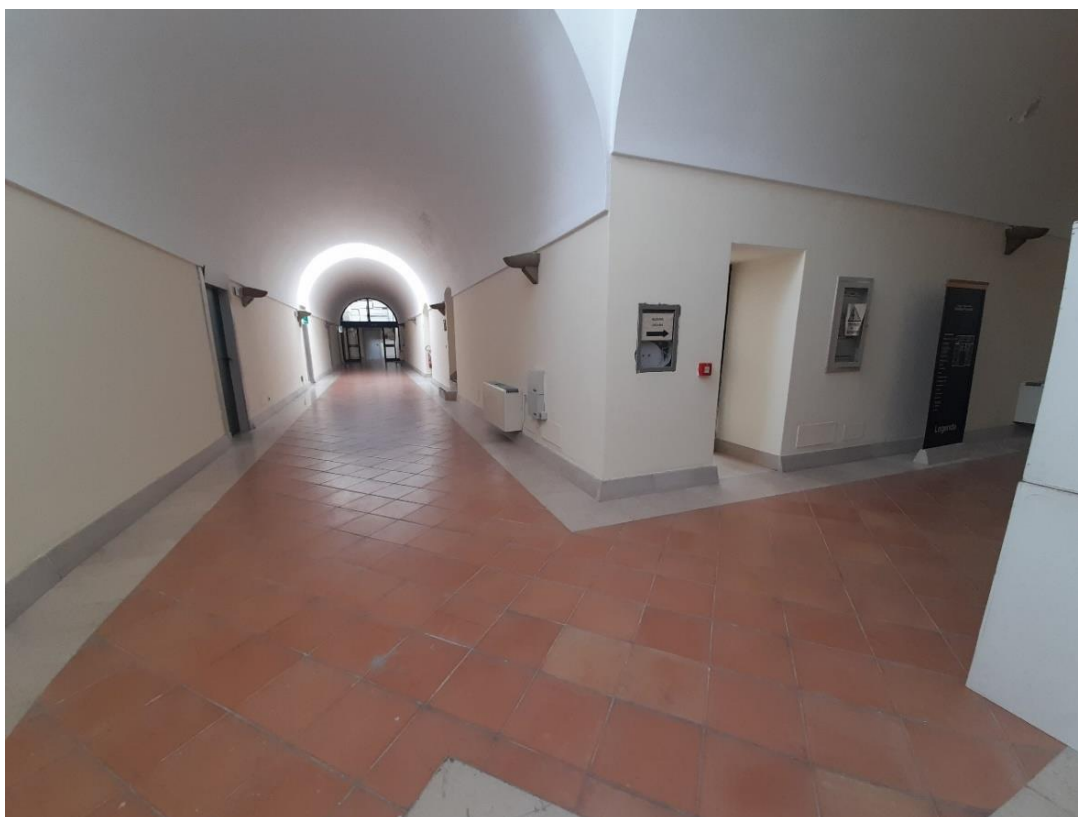
Controcampo ascensore (1) corridoi di distribuzione per gli ambienti
