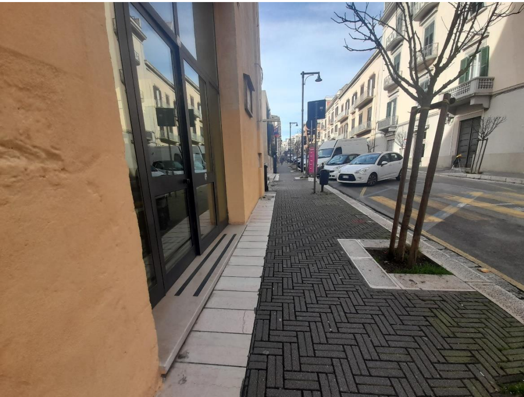
Via Roma –Ingresso principale particolare criticità: H gradino marciapiede presenza alberatura
