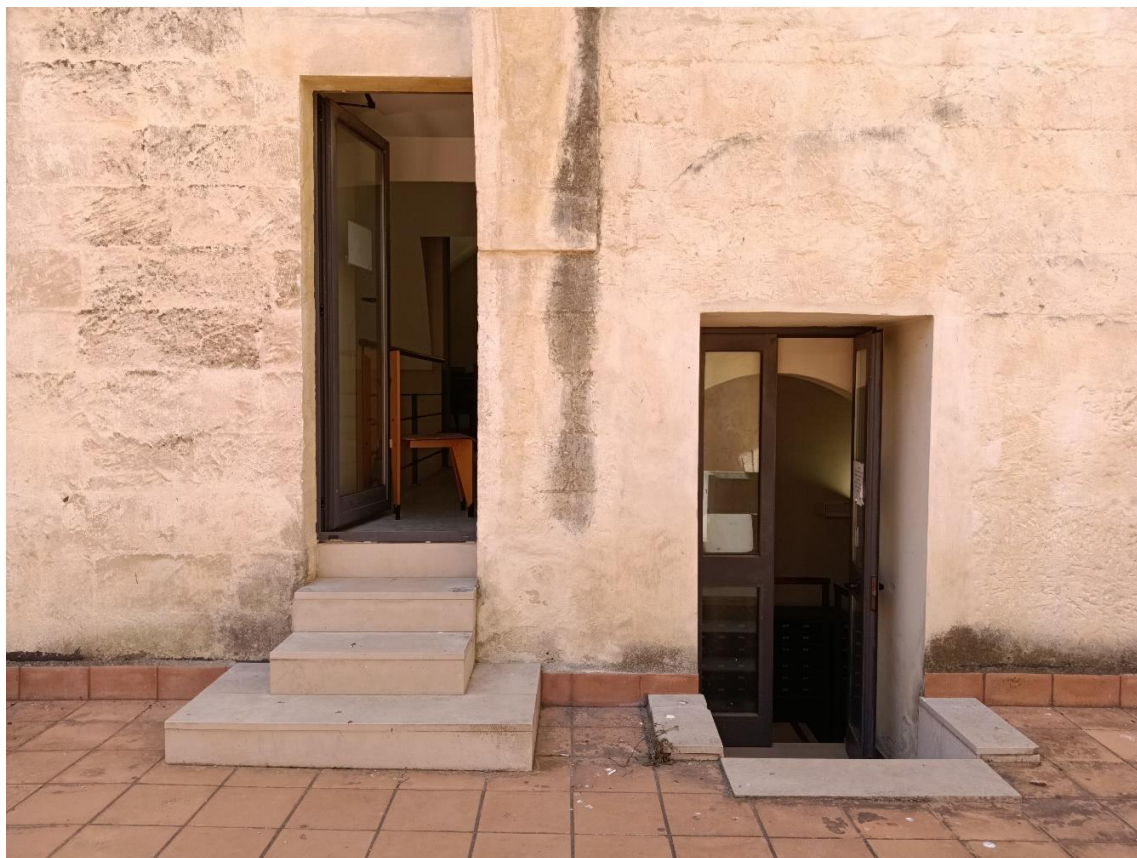
Particolare elemnti di criticità : uscite al Patio/Terrazza
