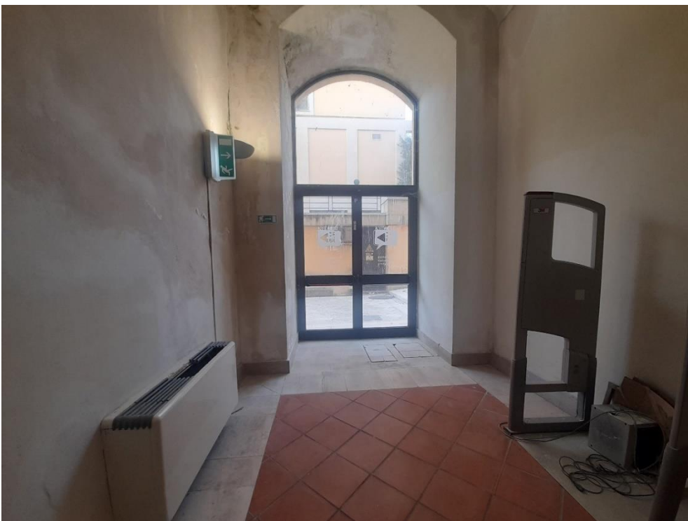
Ingresso secondario- corridoio- Segnalazione uscita di emergenza(vie di esodo)
