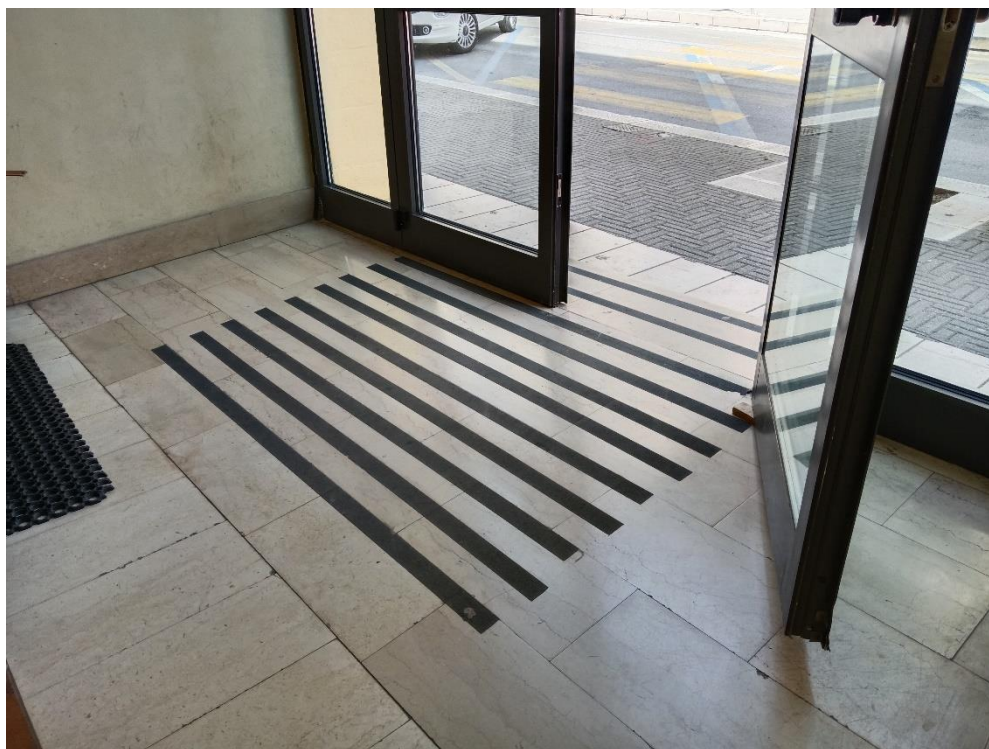
Particolare -Ingresso Atrio- Rampa interna – pendenza 8,00%
