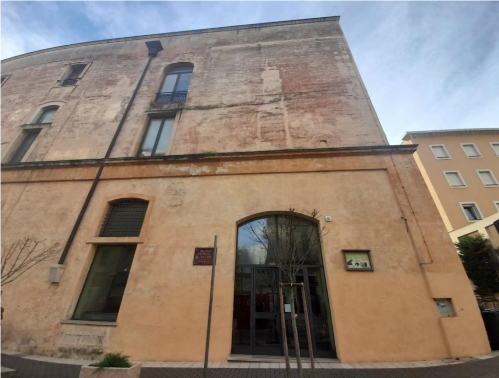
Biblioteca Ingresso principale-Q.+2.05
