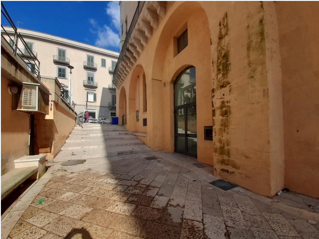
Ingresso secondario- Spazio esterno con panche- particolare criticità : rampa scale
