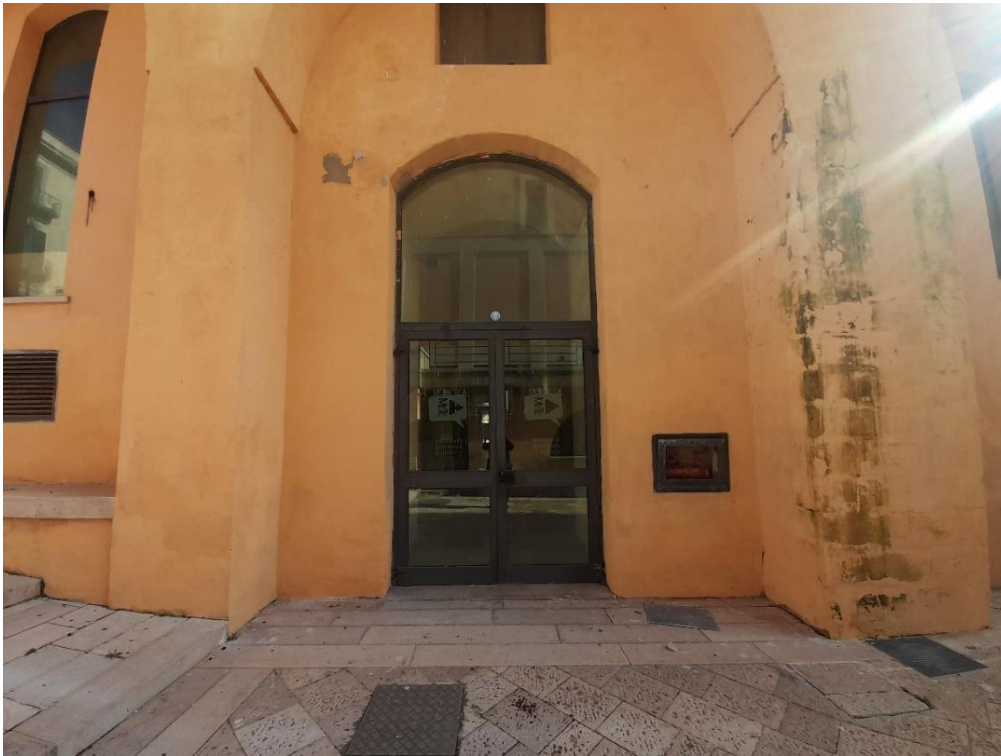
Ingresso secondario- particolare Portone di Ingresso
